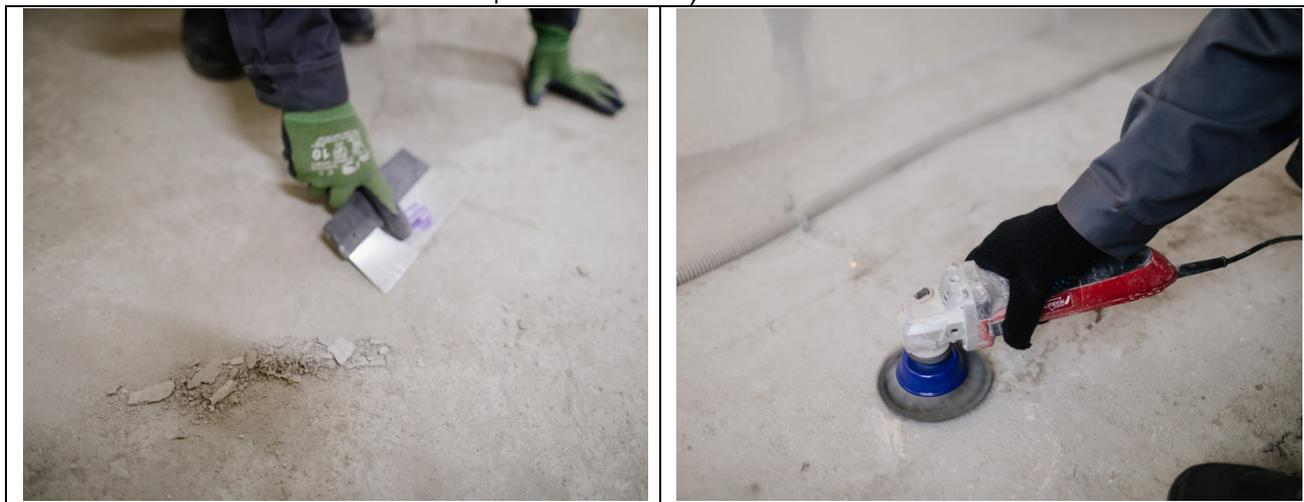
8.1.4. Основание должно быть однородное. Стыки между плитами, трещины, монтажные отверстия, стыки и зазоры в местах примыкания перекрытий к стенам (перегородкам) должны быть заделаны цементно-песчаным раствором на сжатие не менее 15 МПа или ремонтными полимерными составами.
